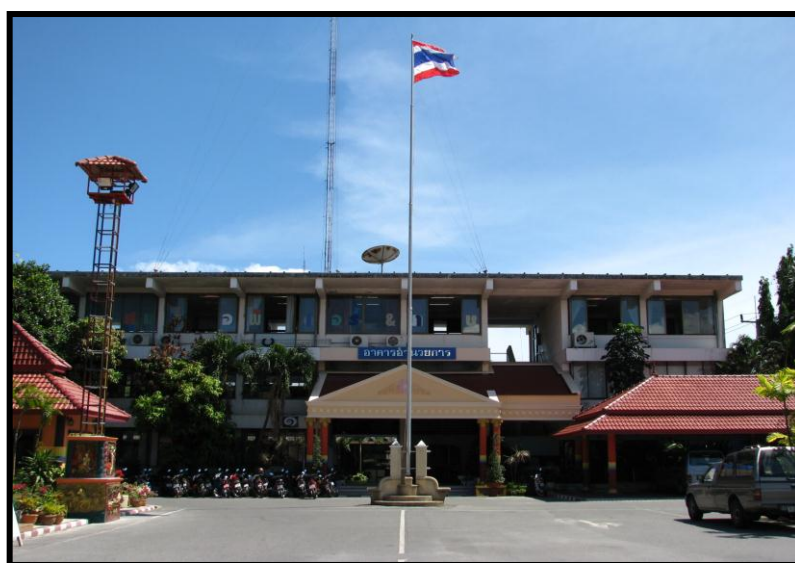
อาคารอำนวยการ
