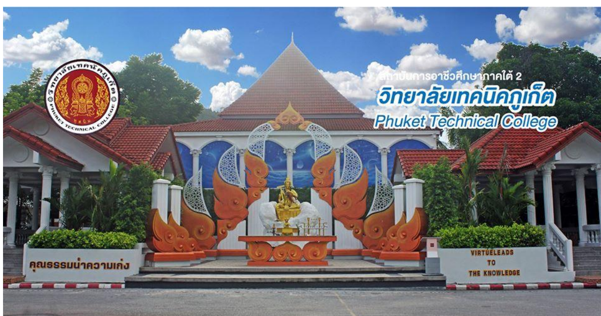
บริเวณลานหลวงปู่และพระวิษณุกรรม
